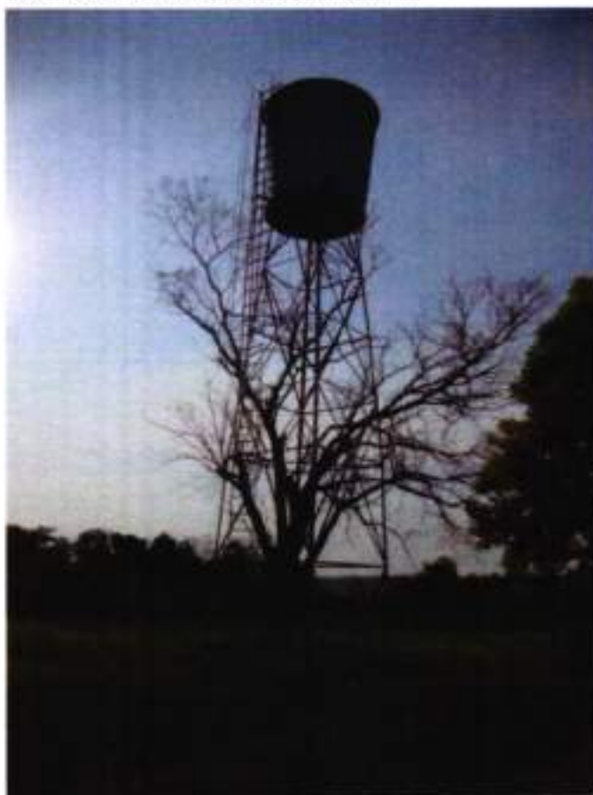
Figura 36 – Reservatório de Rocinha
