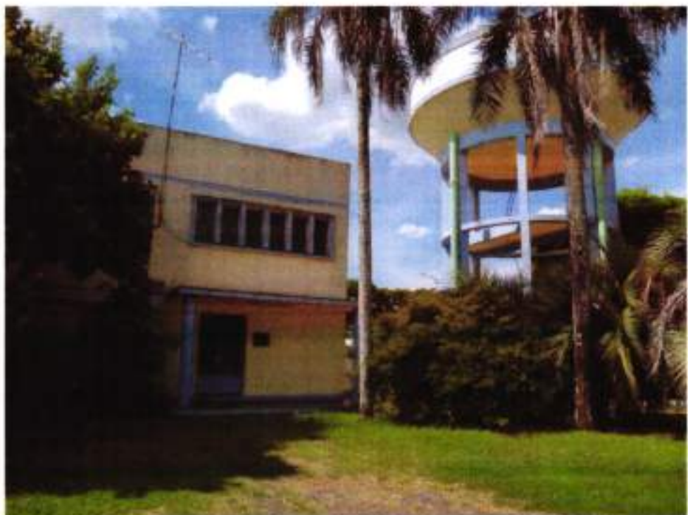
Figura 19 – Instalações da Estação de Tratamento de Água
