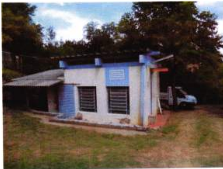
Figura 17 – Instalações no local da captação
