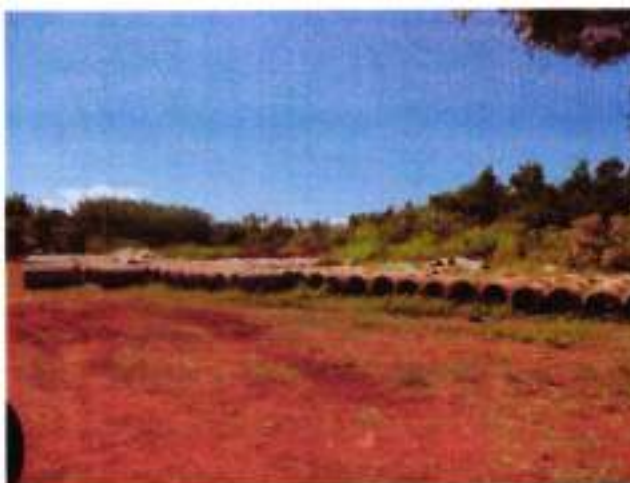
Figura 66 – Obras de drenagem pluvial
