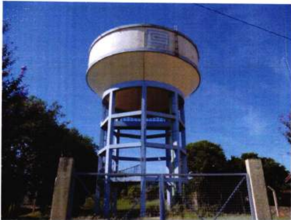
Figura 27 – Reservatório centro da cidade
