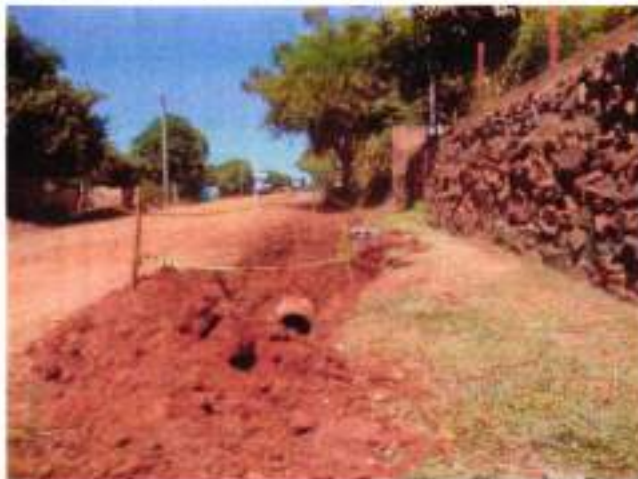
Figura 64 – Obras de drenagem pluvial
