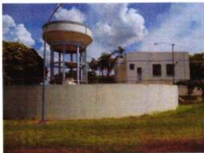
Figura 20 – Estação de Tratamento
