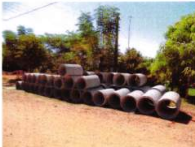
Figura 65 – Obras de drenagem pluvial
