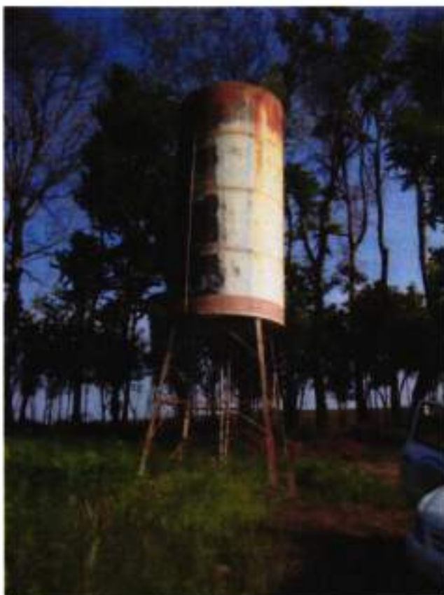
Figura 33 – Reservatório Distrito de Progresso
