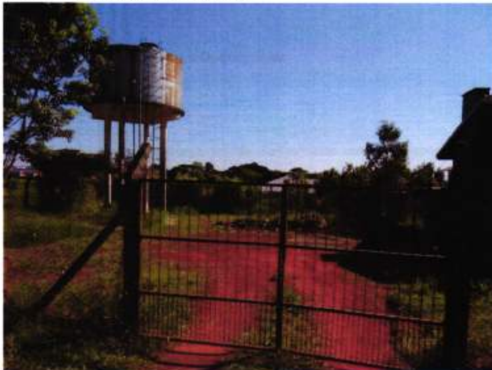
Figura 28 – Terreno próprio com reservatório desativado.
