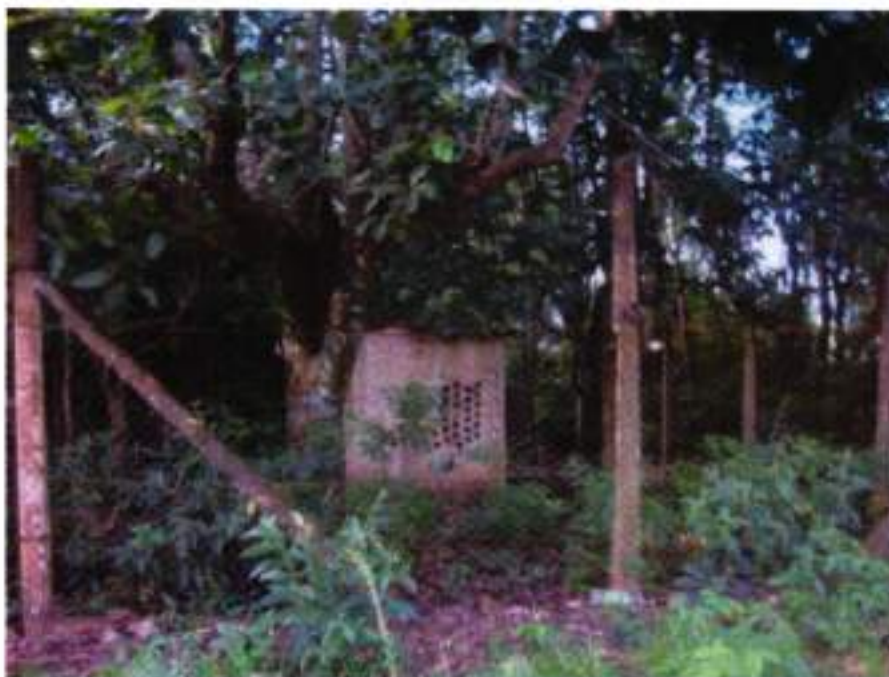
Figura 39 – Poço Artesiano de Consolata
