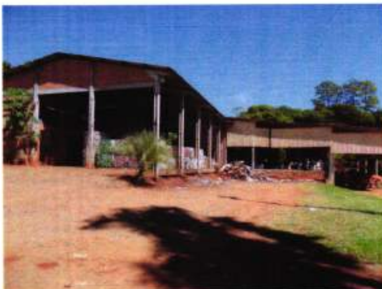
Figura 43 – Instalações do CIGRES
