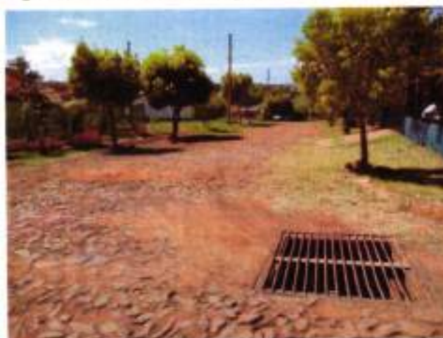
Figura 67 – Sistema de drenagem pluvial
