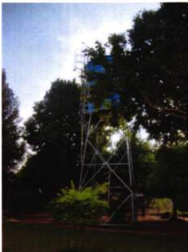
Figura 40 – Reservatório de Consolata
