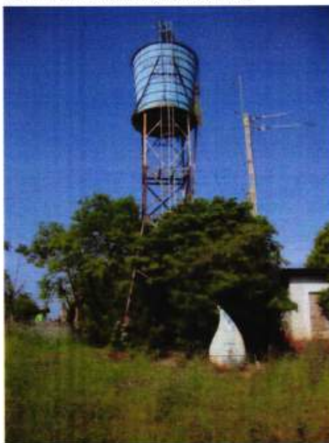
Figura 38 – Reservatório de Manchinha
